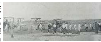
渡辺組で戦前に施工した青島飛行場工事（1938年）
