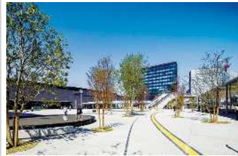
自然石をパーミアコンの構材に使用した「パーミアストーン」の施工事例
