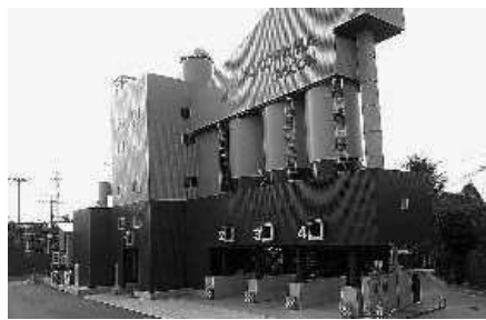
横浜合材工場は乾燥炉でCN都市ガスを使用している
