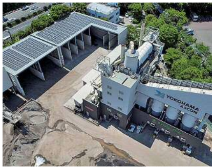
ストックヤード屋根に太陽光パネル287枚設置（伊藤忠エネクス提供）
