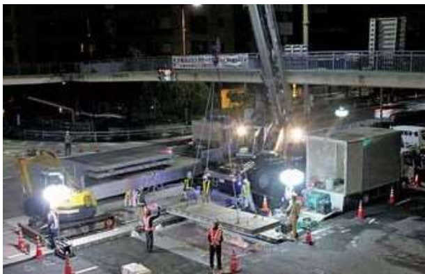
P C a コンクリート版の本設置の様子
