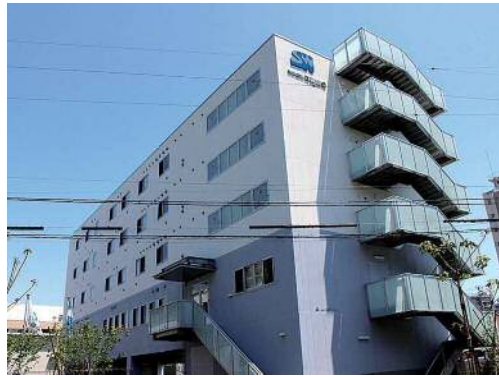
改築が完了した東京営業所
