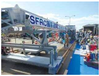
縦取り機の下で接着剤塗布とコンクリート打設を同時に行
