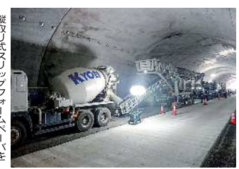
縦取り式スリップフォームペーパーを使ってコンクリートを打設した
