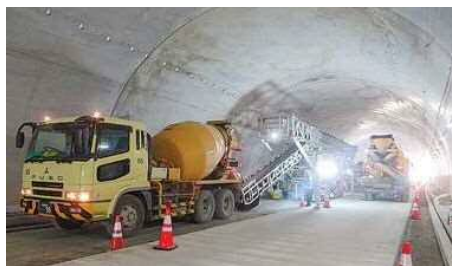
通行車線を確保しつつコンクリートを打設
